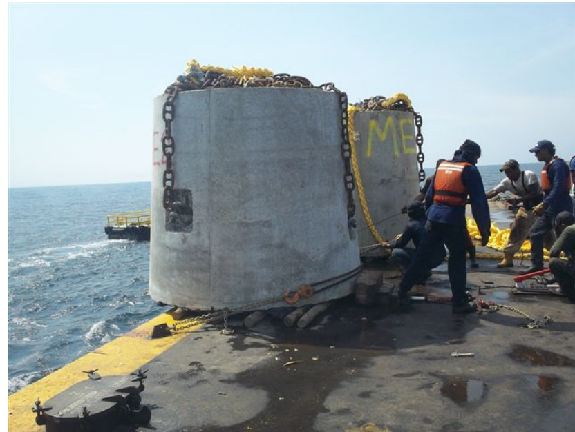
Muertos de concreto de 20 toneladas.
